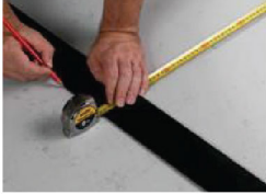
1. การทำเครื่องหมายในตำแหน่งที่มุมของแถบเริ่มต้น และตรงกลางที่แบ่งไว้ทางด้านที่ติดขอบในทั้งสองทิศทางสำหรับตะเข็บ (อย่างน้อย 4 ซม.)
