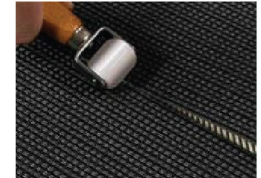
11.5m woven flooring ให้แนบสนิทกับทาบและใช้ลูกกลิ้งทุบให้เรียบรอบตัวให้แนบสนิทมากขึ้น
