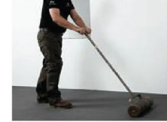
7.5m woven flooring ให้แนบสนิทกับทาบและใช้ลูกกลิ้งทุบให้เรียบรอบตัวให้แนบสนิทมากขึ้น จากนั้นทำซ้ำขั้นตอนที่ 5, 6 และ 7
