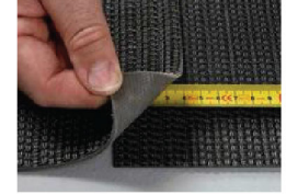
8. ขั้นตอนการ wrap ให้วางเส้นที่แนบไปกับแนวก่อนหน้าเพื่อวางแถบ woven flooring อีกแผ่นต่อไปแผ่นที่ 2 ทุบรอบแผ่นที่ 1 ประมาณ 4 ซม.
