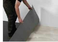
6. วาง woven flooring ที่พับครึ่งตามขั้นตอนที่ 4 ลงไปบริเวณที่ตามมา
